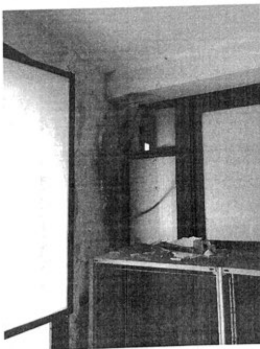
Degrado della parete in corrispondenza della colonna condominiale di scarico interessata dalla rottura
