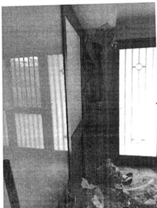
Degrado della parete in corrispondenza della colonna condominiale di scarico interessata dalla rottura
