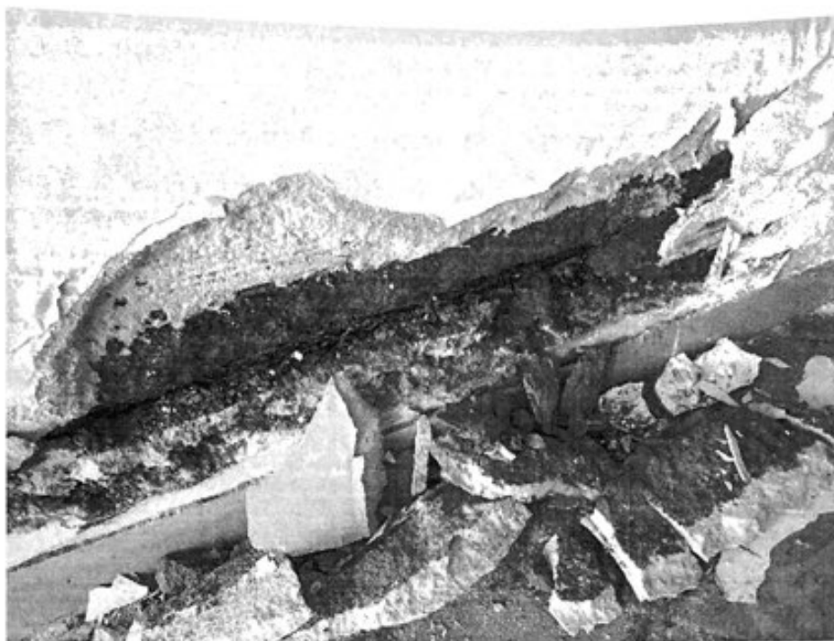
Saggi effettuati per la ricerca del punto di rottura della tubazione privata
